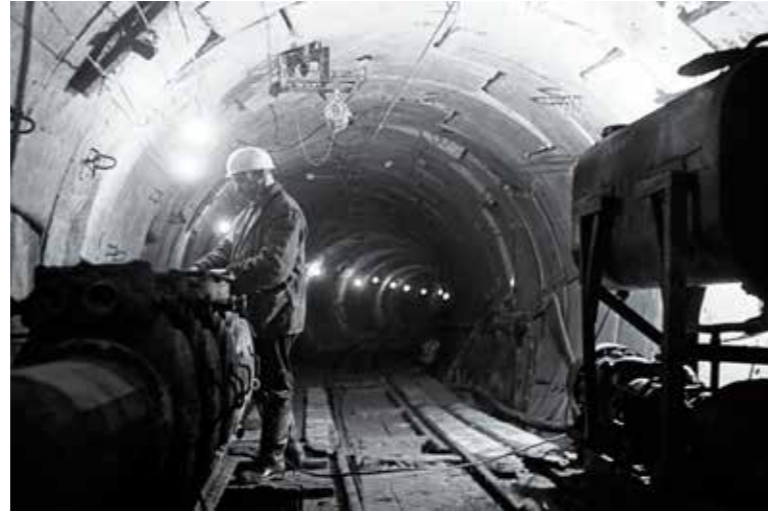
Tallinna heitvee tunnelkollektori ehitus, 1969. (Foto: Gunnar Loss, Rahva Hääl; EFA.250.0-59354)
