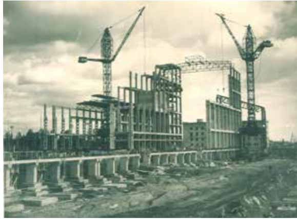
Balti Elektriijaama peakorpuse ehitus, 1958. Eesti pikim hoone – 723 meetrit. (Foto: Eesti Energia Balti Elektriijaama muuseum)
